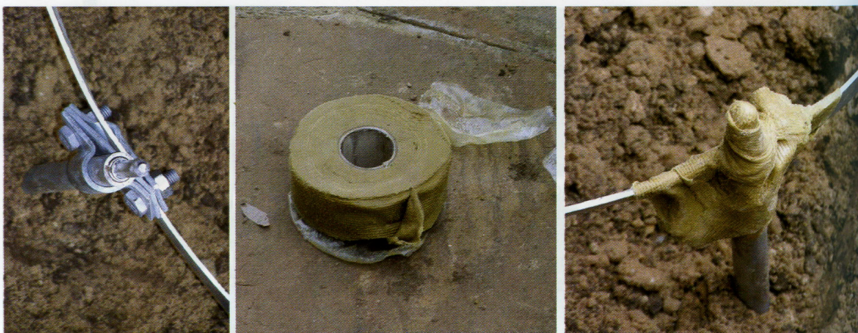
Рис. 5. Антикоррозионная лента и пример герметизации соединений в грунте
