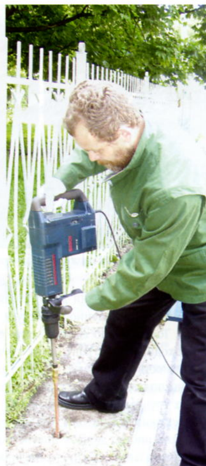
Рис. 4. Забивка стержня вибромолотом (фото из архива компании Watson Telecom)
