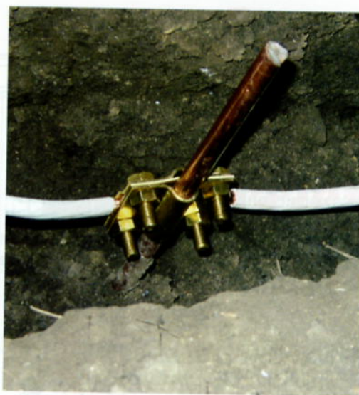
Рис. 3. Присоединение горизонтальной магистрали к стержню и сам зажим (крестовой)
