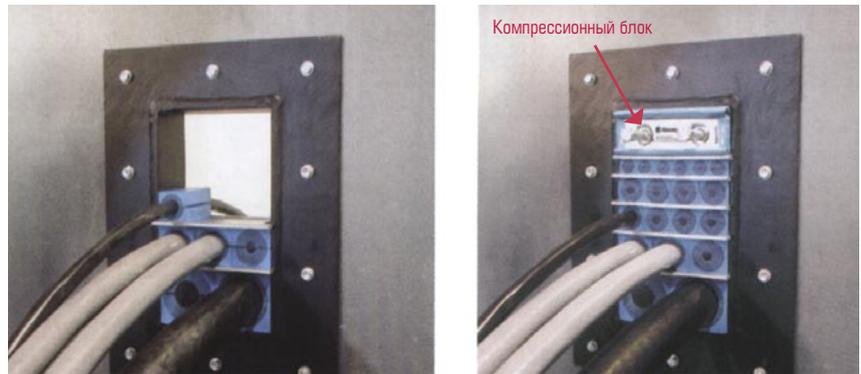
Рис. 15. Монтаж кабельной проходки на основе модульных уплотнителей фирмы Roxtec
